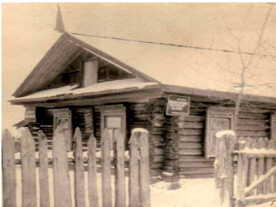
Здание начальной школы (с 1968 г – сельский клуб)
