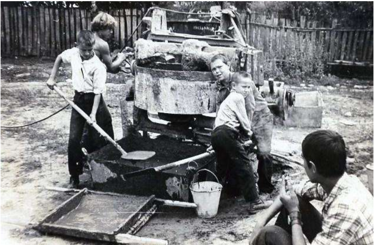
Растворо-бетонный узел, 1983 г
