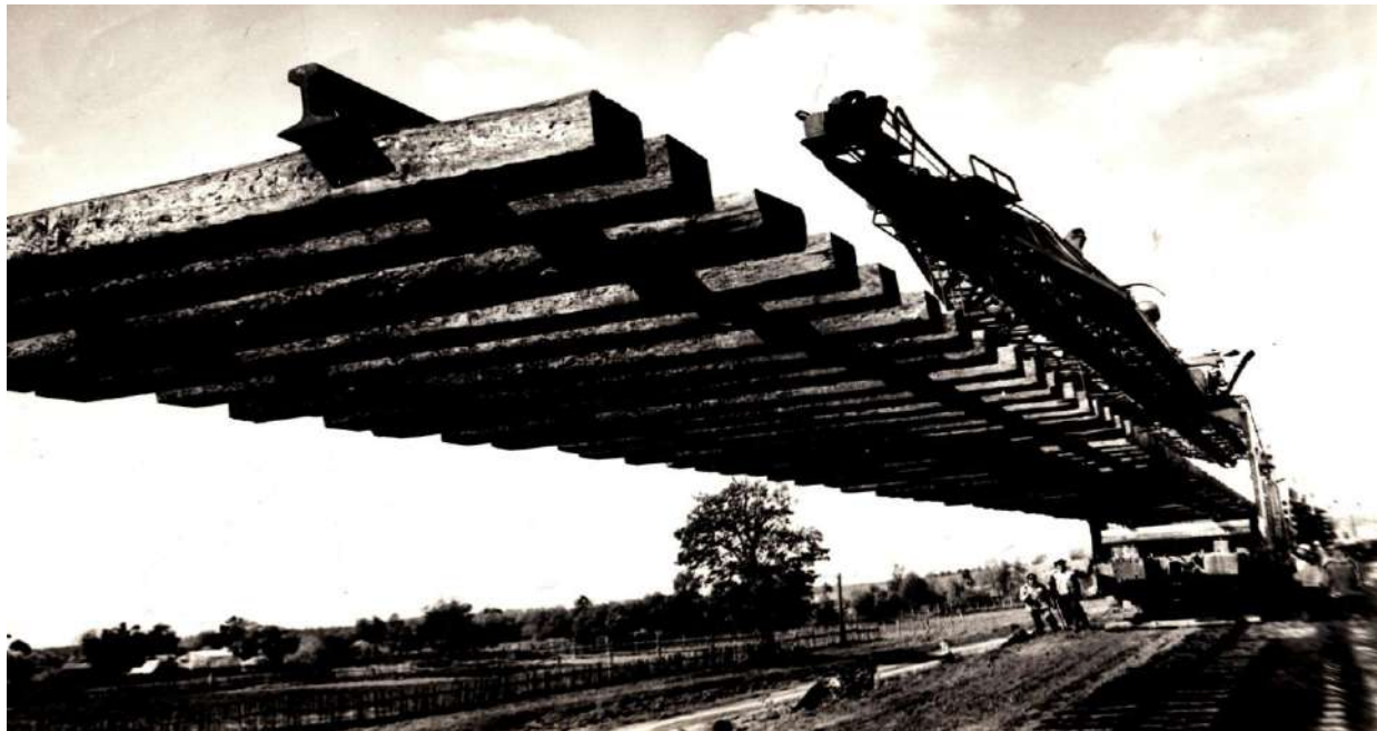
Укладка железнодорожного звена около деревни Тохмеево 1999 г
